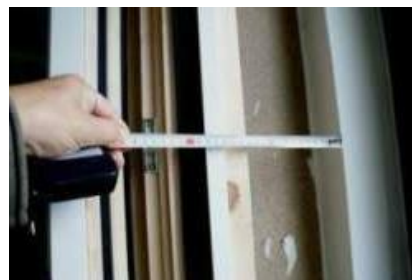
25 cm Innendämmung mit 3-Scheibenverglasung
