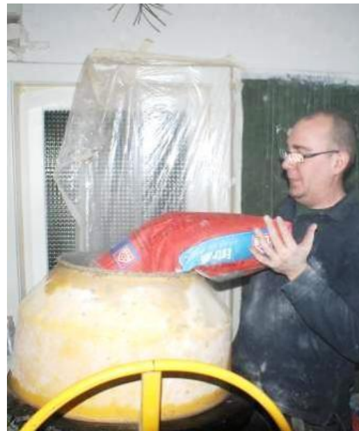
Mischen des Zementmörtels in der Wohnung
