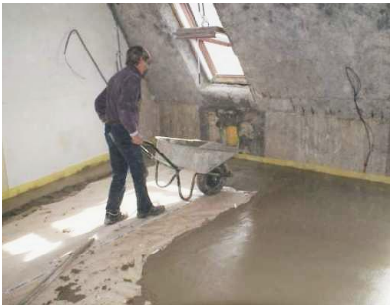
Einbringen des Nassestrichs auf 2 cm Ausgleichsschüttung und Isover TDPT- Trittschall-Dämmplatte 2,5 cm
