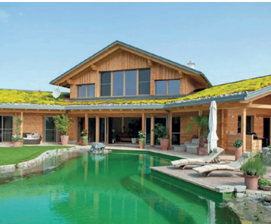
Ökohaus mit Erdwärmepumpe/Flächenkollektor
