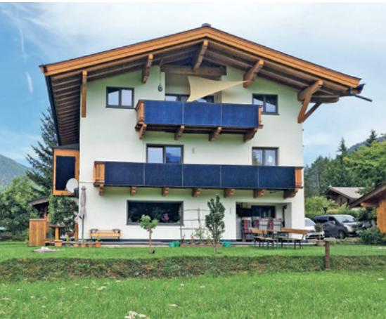
Zweifamilienhaus mit Erdwärmepumpe/Tiefenbohrung
