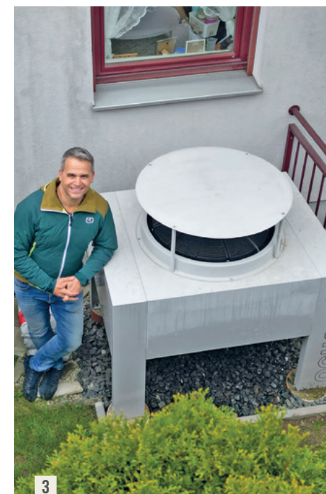
[2] Hausherr Andreas Redl ließ die beiden in Kaskade geschalteten Monoblock-Luftwärmepumpen Modell CHA10/400V von WOLF an die Wand des Carports montieren.
